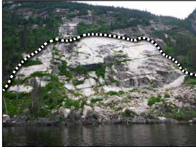
Zone de glissement important sur un escarpement du lac Walker. On peut apercevoir en bas de la pente les matériaux meubles qui ont été mis en mouvement avec des blocs délogés de la paroi. Ce glissement se serait produit en 2009.
